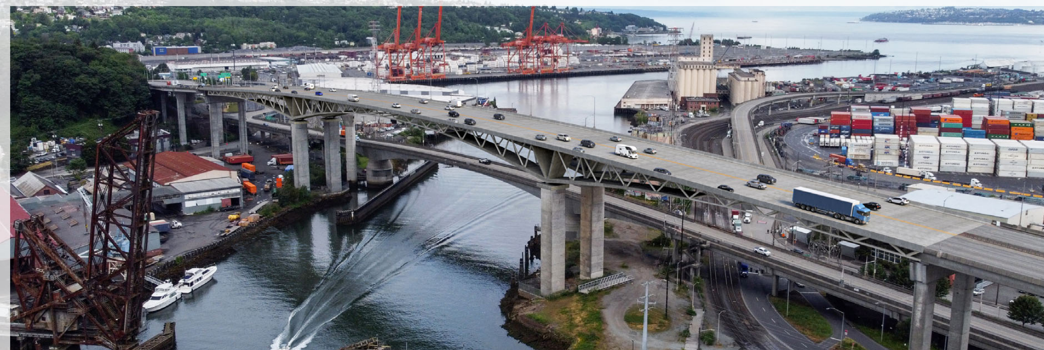
Rendu pour le pont West Seattle, WA, ÉTATS-UNIS 12
