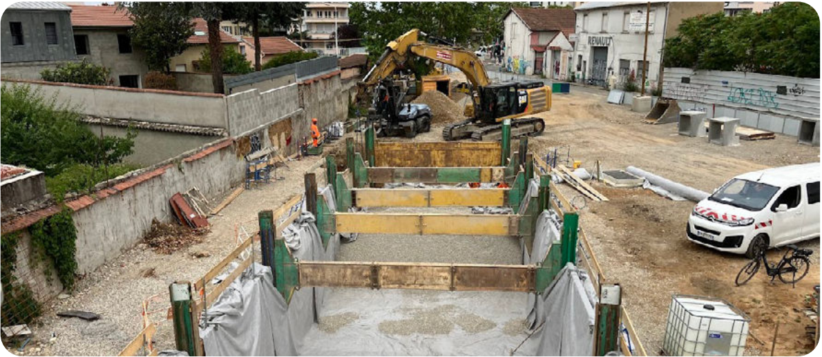
Tranchée d'infiltration sous la plateforme tramway de T6 nord à Lyon – l'écoconception permet de désimperméabiliser 8 hectares, soit 55 % des surfaces sur les 6 km de tramway. MOA : Sytral Mobilités, Entreprise (lot Infrastructures et voie ferrée) : Groupe NGE, MOE : Egis (mandataire)
