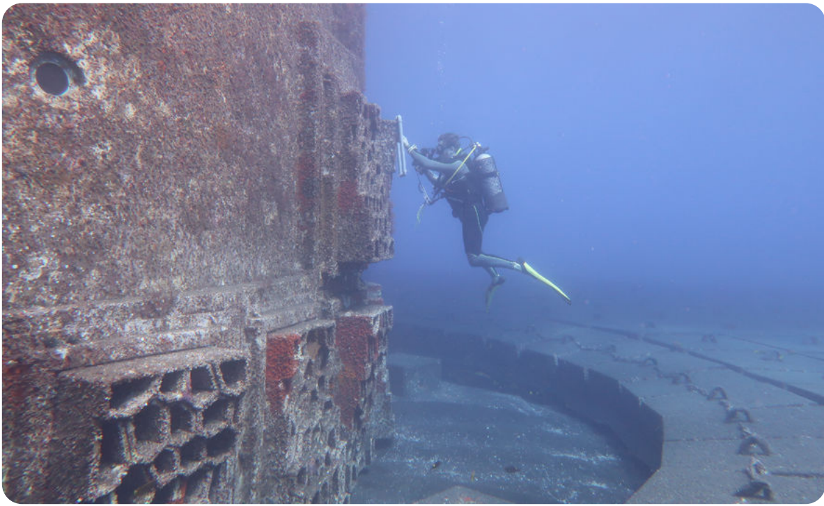
Dans le cadre du projet de Nouvelle Route du Littoral, les aménagements prévus ont proposé une écoconception au niveau de certaines piles du viaduc. Cela a notamment consisté en l'ajout de modules éco-conçus, créant des habitats favorables à la vie sous-marine. En plus des tapis anti-affouillement disposés au pied des piles, cela permet le développement de nombreuses espèces, dans un environnement initialement plus pauvre (milieu sédimentaire). Les différents suivis réalisés ont montré un développement marqué de la biodiversité marine. MOA : Région Réunion Consortium pour la construction du viaduc : Demathieu Bard Construction / Bouygues TP / Dodin Campeno Bernard / Vinci Construction MOE : Egis / AMOE : Biotopie (Assistant à Maître d'Ouvrage Environnemental)
