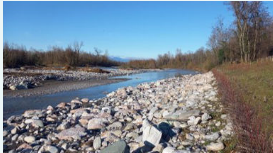
Protection de berges en techniques végétales (couches de branches à rejets)
