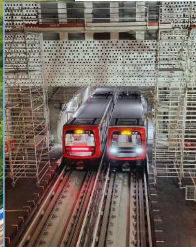
Prolongation du métro B aux Hôpitaux Sud EOLE, Lyon | SYTRAL Mobilités
