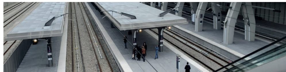
RER E | 47 km, 8 km de tunnel entre la Défense et Haussmann Saint-Lazare SNCF Réseau | AMO, Essais d'intégration, Mission d'appui aux Directions d'Opérations
