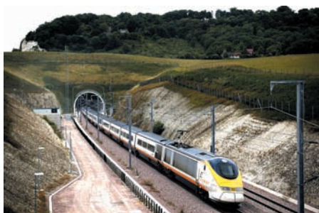
Sortie du tunnel de North Downs ↓
