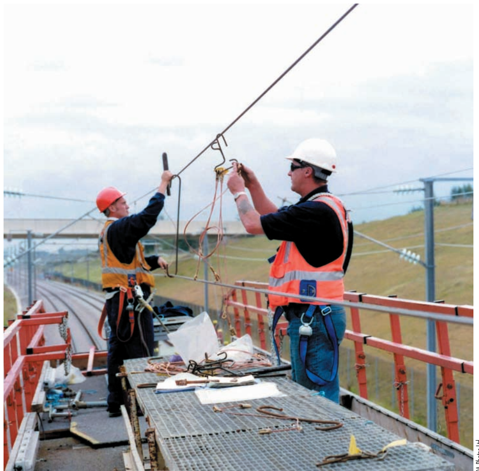
Installation des caténaires ↓
