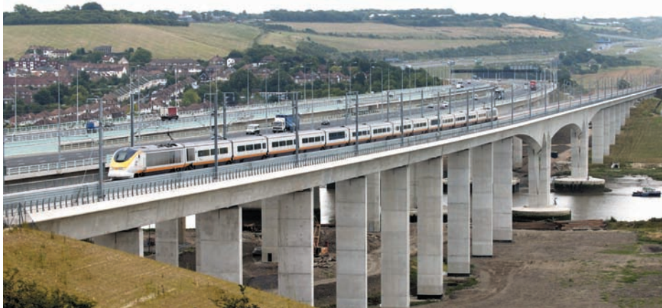
Le viaduc de Medway ↓
